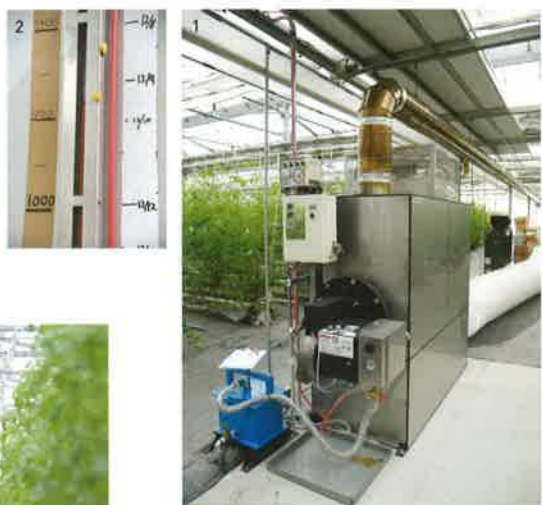
1.重油ボイラー。煙で温められた煙突をできるだけ長くハウス内に遣わして放熱。重油より先に点火する設定で、11月くらいまではこれだけで十分温まる。これをベースに、足りなくなったら重油ボイラーを補助的に炊く。2.隣の重油ボイラーでは重油の使用量を記録。1日で100〜150Lを使う。
