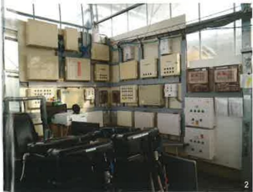
1. 事務所には新しい統合環境制御装置のモニターが並ぶ。「環境がかなり改善した。かなり使い勝手も良いし、以前の状態には戻れないですね」。2. 機械室には統合環境制御盤などがぎっしりと並ぶ。
